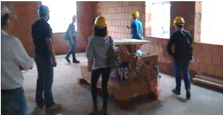
Illustrazione 4-1. Secondo meeting, materiale specchio. Gli studenti effettuano misurazioni all'interno di un edificio in costruzione
